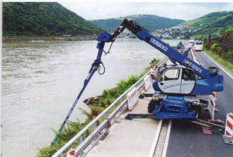
... mit einer 3D-Gondel-Arbeitsbühne ist der Teleskopstapler eine echte Alternative zu konventionellen Maschinen für Arbeiten an Stützmauern und Brücken. Mit der 3D-Gondel-Arbeitsbühne war es möglich, an der Stützmauer sowohl Unterflur- als auch Überflur-Arbeiten durchzuführen. Der Arbeitskorb bot mit maximaler Tragkraft von 200 kg ausreichend Kapazität für den Prüfer und sein Werkzeug.
