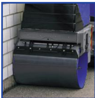
Verdichten bis an Mauern
